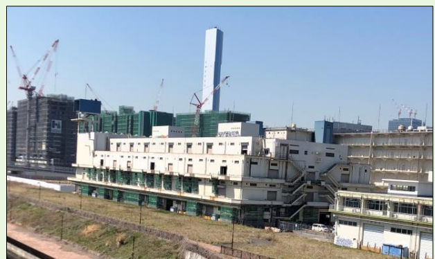
運営施設の整備状況（改修工事）
