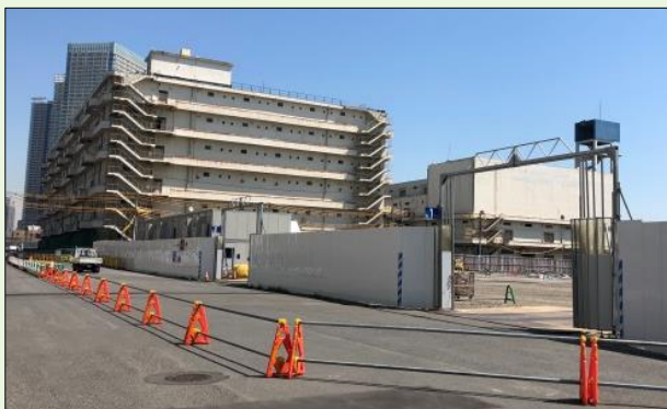
運営施設の整備状況（ くだい 躯体工事）
