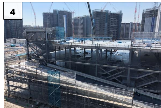
4 5-7 街区 地上躯体 くたい の整備状況
