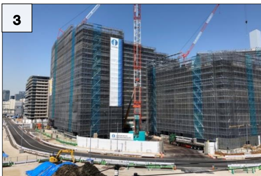
3 5-6 街区 地上躯体 くたい の整備状況
