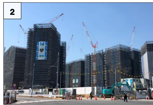
2 5-5 街区 地上躯体 くたい の整備状況
