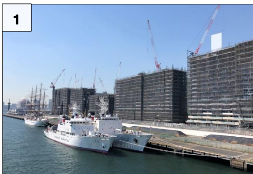
1 5-4 街区 地上躯体 くたい の整備状況
